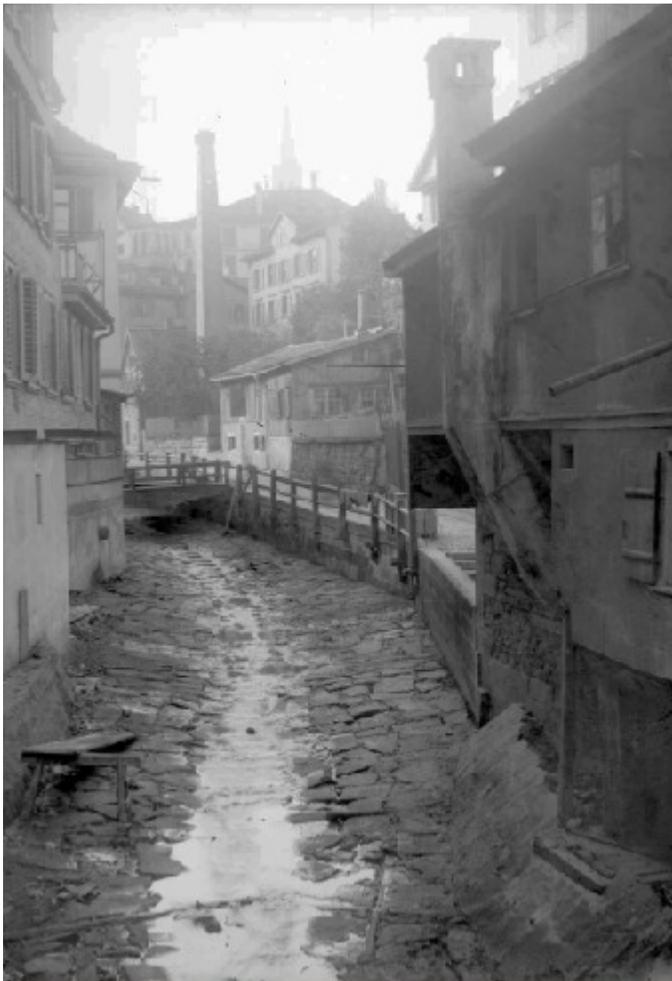
Sehr gut erkennbare total-systemische Subordination, d.h. die Keller stehen auf dem Niveau des Flußbettes, während die Hauseingänge auf dem Niveau der Lämmli brunnenstraße (rechts) stehen, deren Niveau allerdings mit der Überdeckung der Steinach erhöht wurde.
